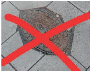
Schacht- und Kappenumpflasterungen sind die einfache, passgerechte und dekorative Lösung im öffentlichen Straßen- und Wegebau um Deckel von Wartungs- und Kontrollschächten sicher einzufassen. Die Außenkontur der verlegten Pflastersätze erlaubt das Anlegen der sie umgebenden Pflasterung mit nur geringem Verschnitt.
